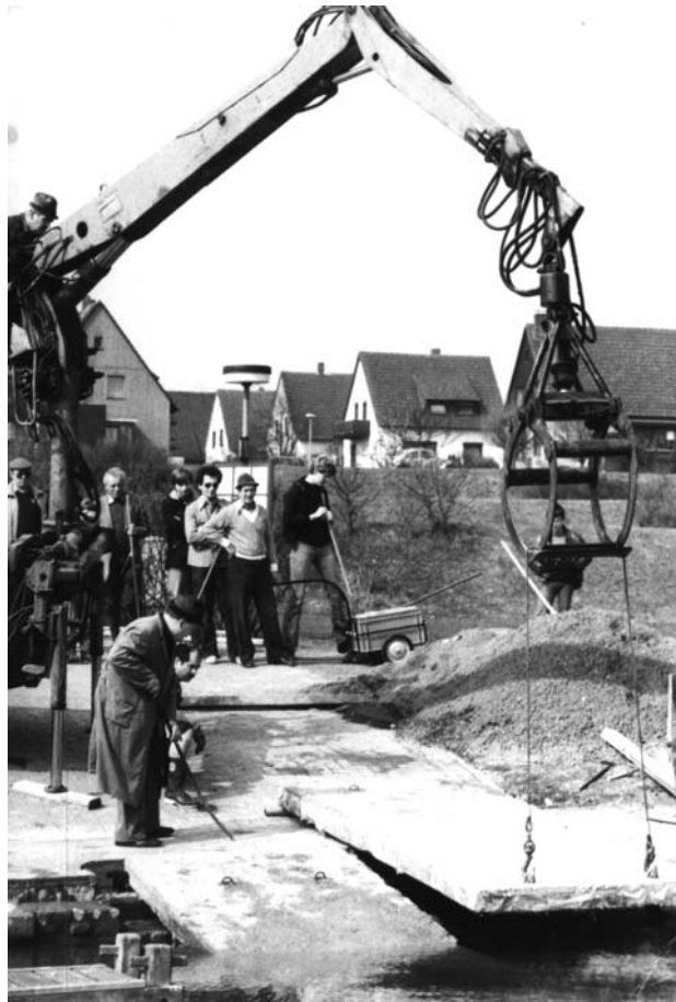
Bauarbeiten an der Slipanlage
